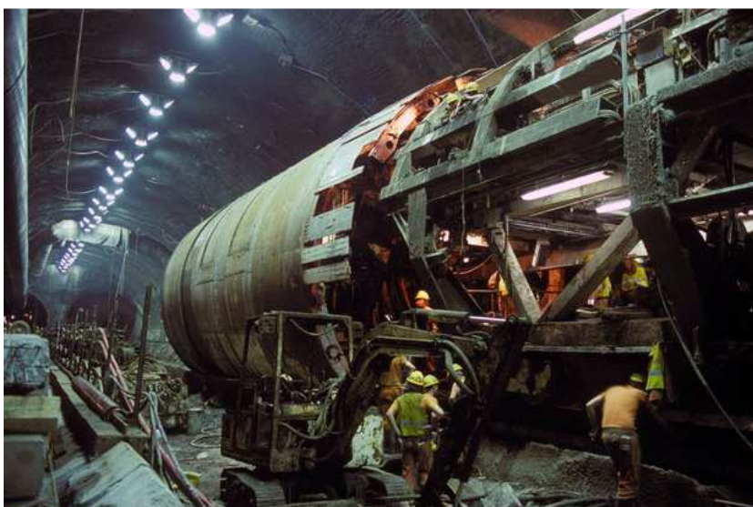
Operai al lavoro in un cantiere sotterraneo
